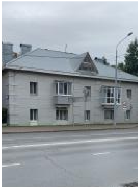
16. Жилой дом, ул. Курильская, 2
