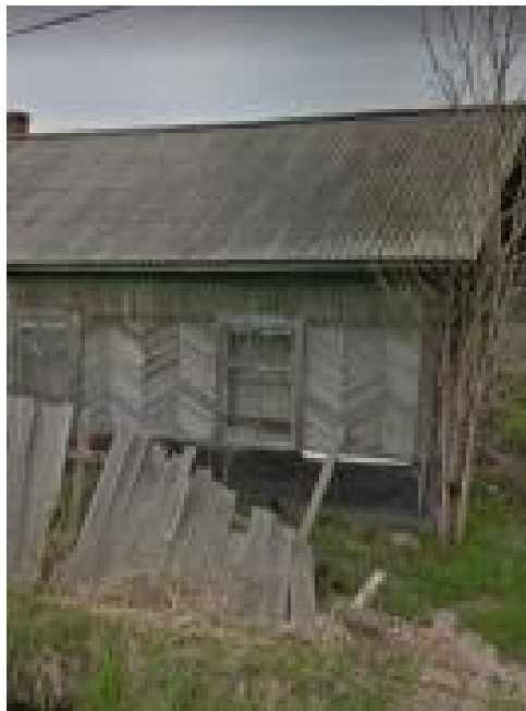
56. Индивидуальный жилой дом, ул. Кирпичная, 39
