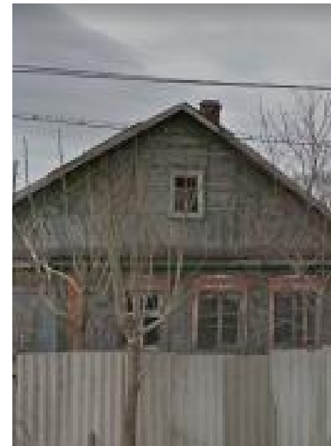
59. Индивидуальный жилой дом, ул. Кирпичная, 63
