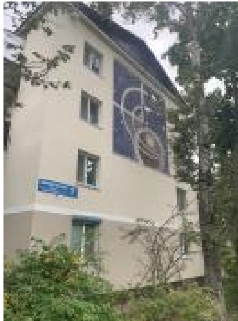
31. Жилой дом, Коммунистический пр-т, 7
