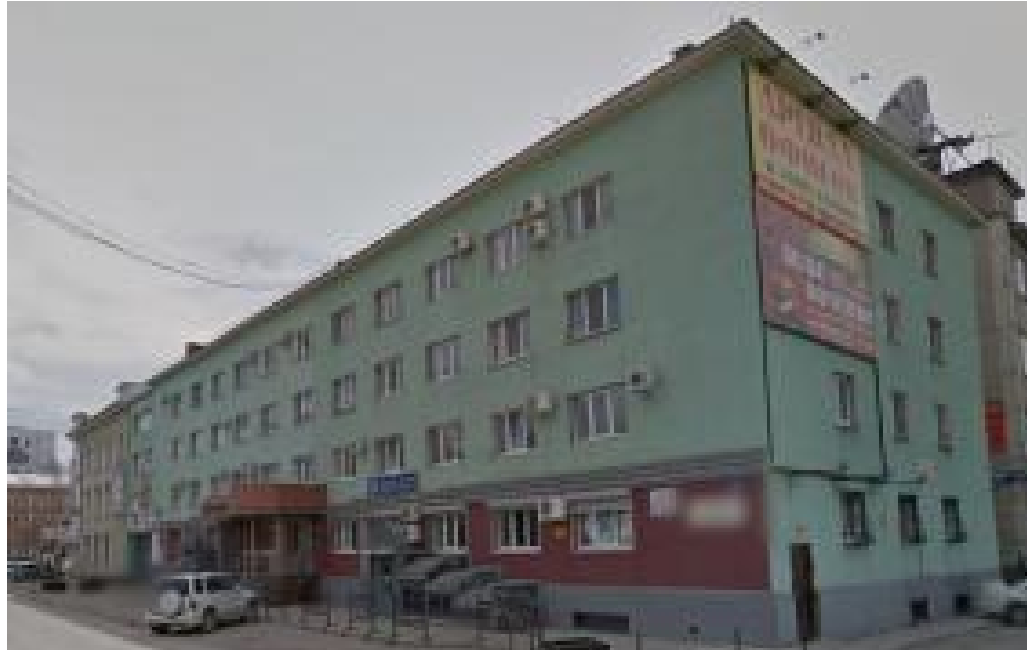
72. Жилой дом, ул. Амурская, 62
