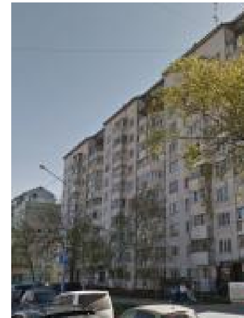
60. Жилой дом, ул. Дзержинского, 38
