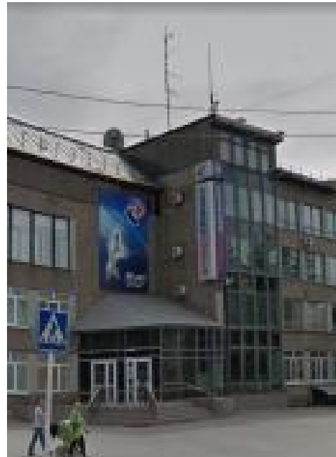
63. Сахалинэнерго, Коммунистический пр-т, 43
