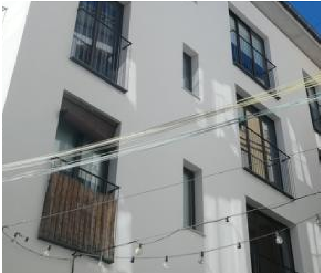
Окраска по штукатурке
