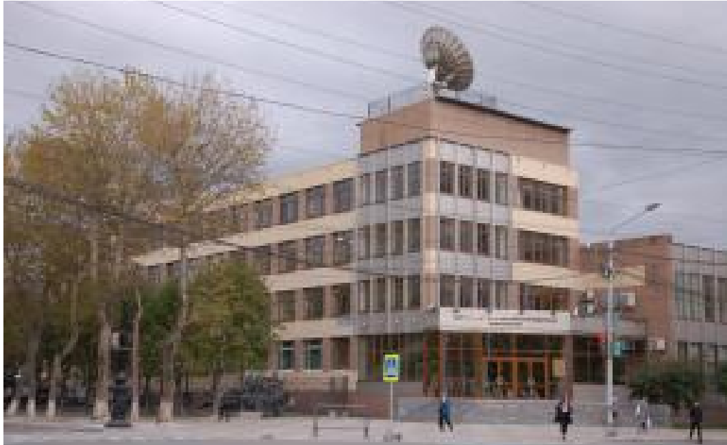
71. Коммерческое здание, ул. Амурская, 59
